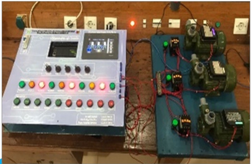
Hasil Kerja Alat Pada Kontrol Pompa
