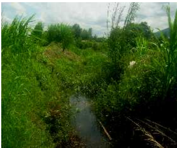
Gambar 3. Air Yang Menggenang Pada Saluran Tanah
