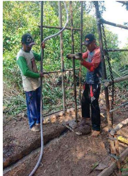
Gambar 10. Pipa besi berulir dimasukkan ke dalam tanah
