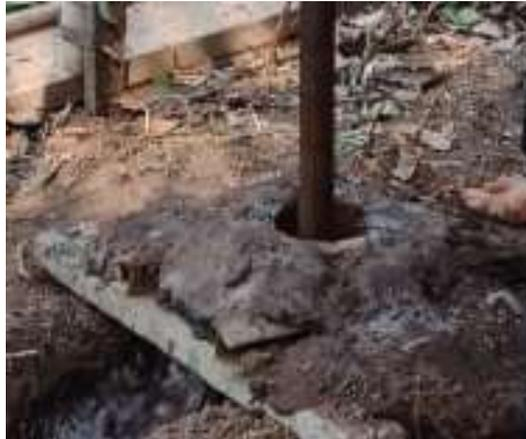
Gambar 11. Pemasangan pipa sebagai penopang tanah
