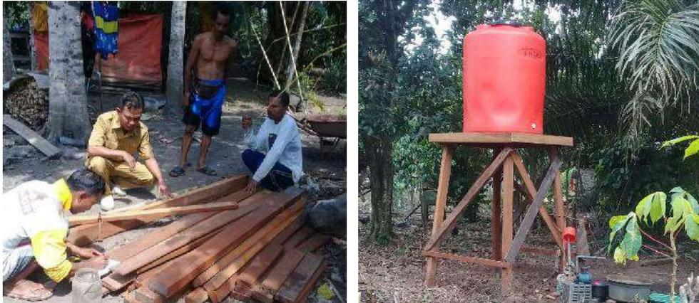
Gambar 18. Proses instalasi rangka penyangga tandon
