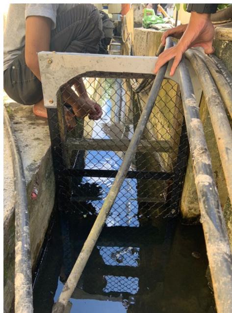
Gambar 5. Pemasangan jaring pengaman Saluran
