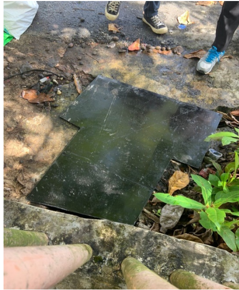
Gambar 6. Pemasangan jaring pengaman Saluran
