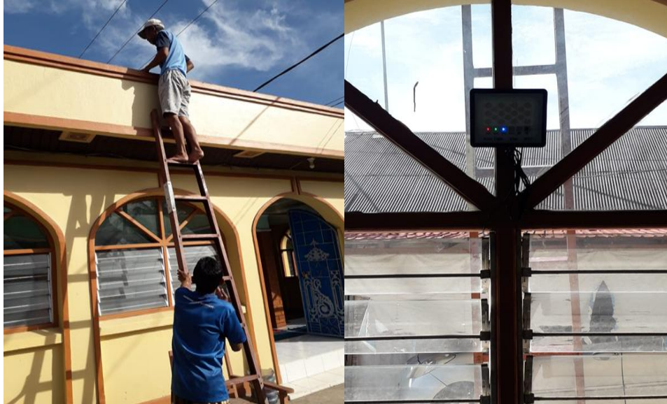
Gambar 4. Pemasangan Instalasi Emergency Lamp
