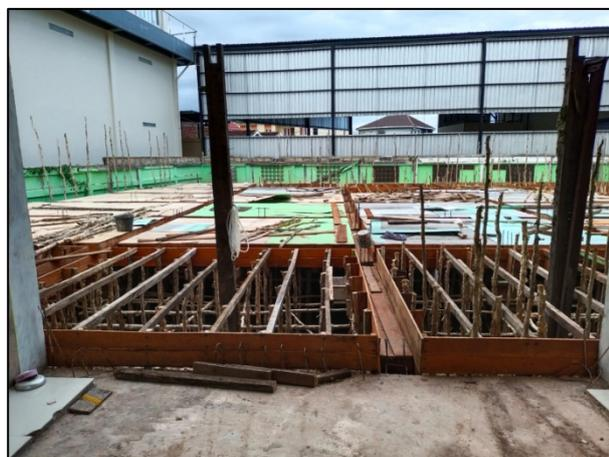
Gambar 11. Pekerjaan Bekisting Lantai dan Balok
