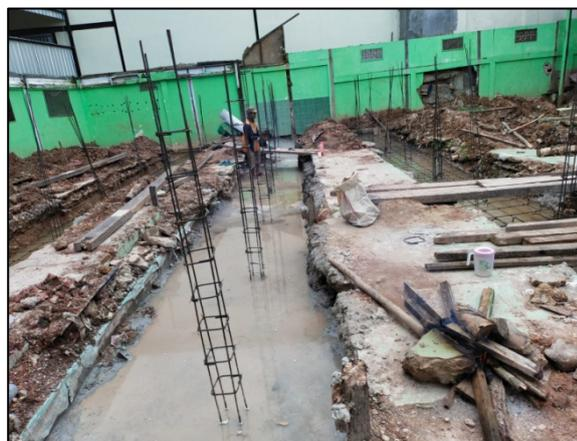
Gambar 9. Pekerjaan Pengecoran Beton K-250 Pile cap
