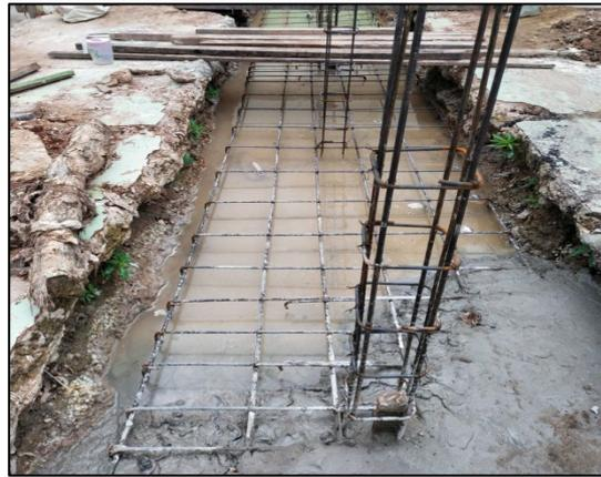
Gambar 8. Pekerjaan Pengecoran Beton K-250 Pile cap
