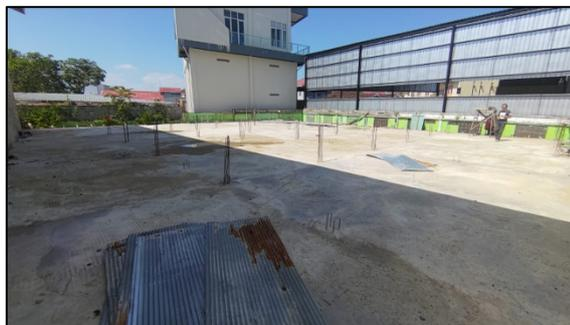
Gambar 12. Pengecoran Beton K-250
