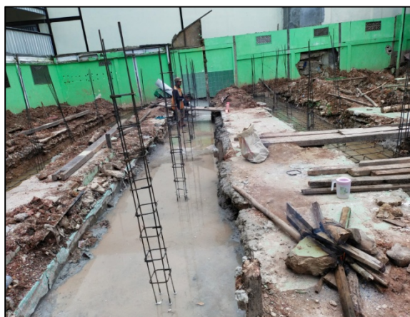
Gambar 9. Pekerjaan Pengecoran Beton K-250 Pile cap
