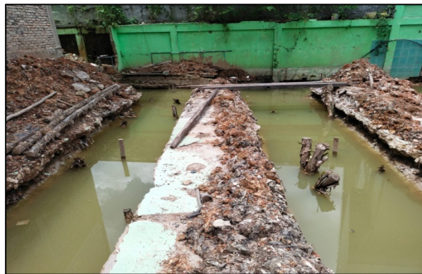
Gambar 6. Pekerjaan Pancang Galam
