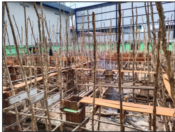
Gambar 10. Pekerjaan Struktur Top Ring Balok dan Plat Atap Dak
