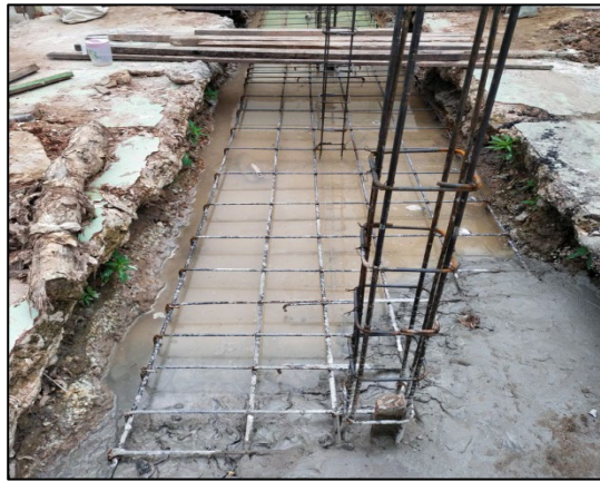
Gambar 8. Pekerjaan Pengecoran Beton K-250 Pile cap
