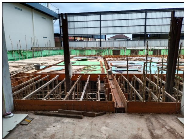
Gambar 11. Pekerjaan Bekisting Lantai dan Balok
