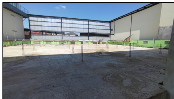
Gambar 13. Pengecoran Beton K-250
