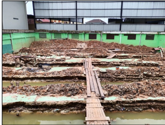
Gambar 4. PekerjaanPembesian Pile Cap
