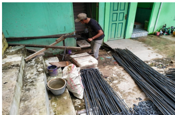
Gambar 7. Pekerjaan Perakitan Pembesian Pile Cap
