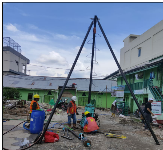
Gambar 5. Pekerjaan Pemancangan Galam
