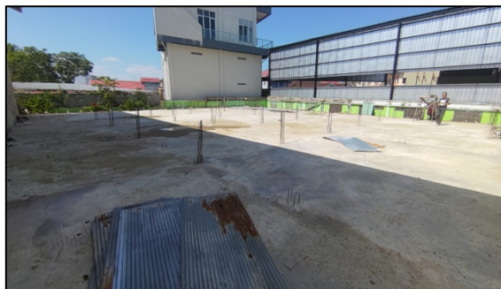
Gambar 12. Pengecoran Beton K-250
