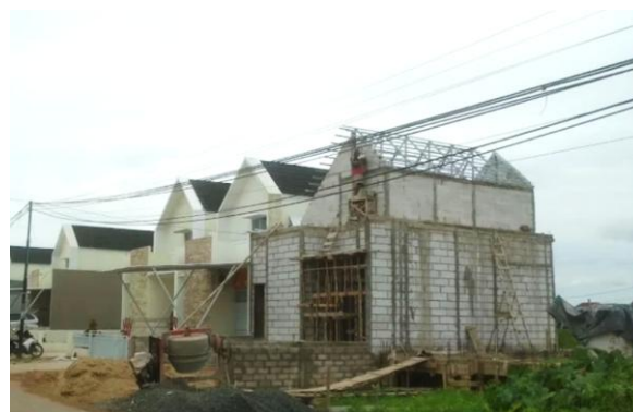
Gambar 14. Pemasangan Dinding Konvensional di Lapangan
