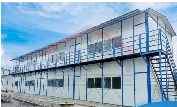
Gambar 13. Bangunan dengan Dinding Precast
