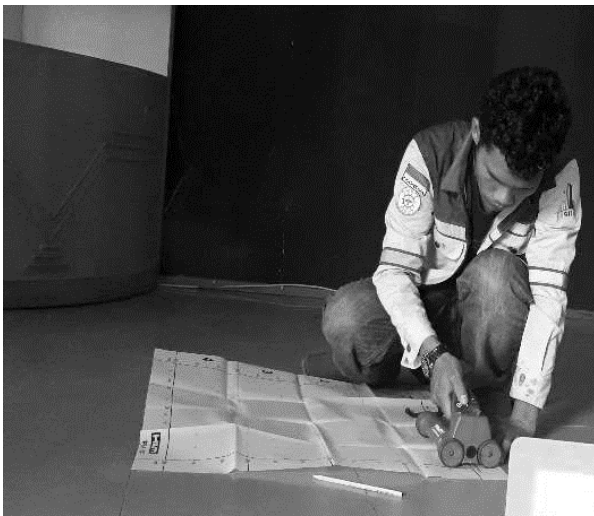
Gambar 8. Rebar Scan Gedung Plasa Telkom Padang Sidempuan
