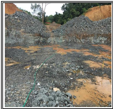
Gambar 13 Kondisi galian sesuai desain area Saddle dam. Arah kamera ke Hulu/Upstream
