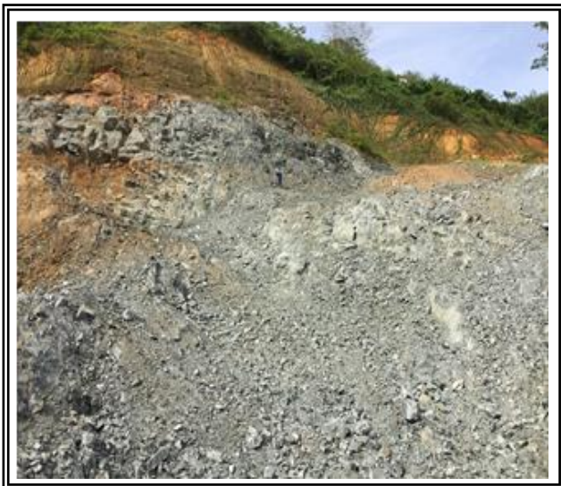
Gambar 4. Kondisi batuan di area Maindam kiri bagian permukaan setelah dilakukan penggalian sesuai dengan elevasi desain
