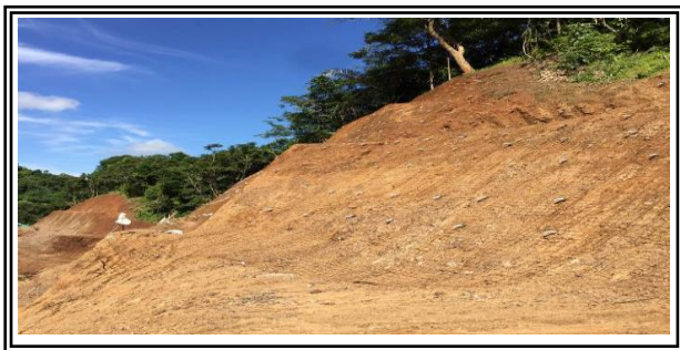
Gambar 16. Kondisi galian lapisan Tanah area saluran Pelimpah
