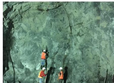
Gambar 23 Kondisi batuan setelah peledakan di area Terowongan
