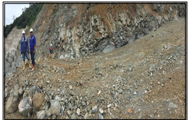
Gambar 18 Kondisi batuan andesit yang menunjukkan adanya kekar tiang pada bagian dinding kanan area spillway
