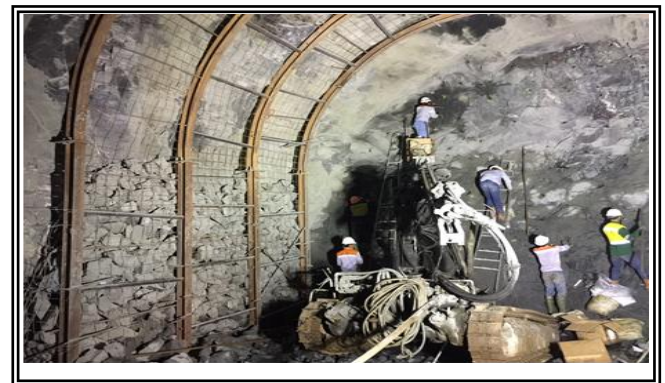
Gambar 22 Metode pemboran dengan alat Crawler Rock Drill
