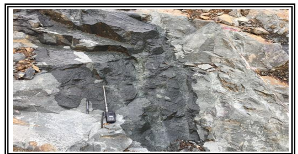
Gambar 12 Kondisi galian batuan Andesit keras pada Sta.2 upstream saddle dam.
