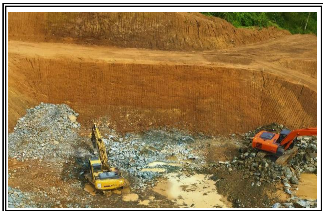
Gambar 10 Kondisi galian tanah dan batuan area saddle dam
