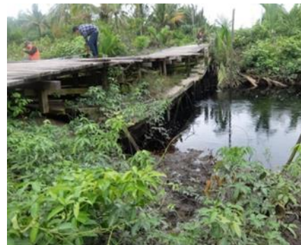
Gambar 2 Kondisi jembatan Sungai Nipah (Sumber: Dokumentasi kondisi jembatan saat ini)
