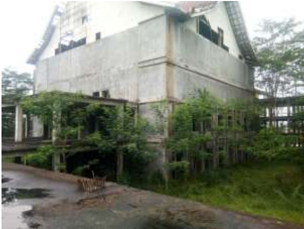
Gambar 4. Existing Gedung Tengah RSP UNJA (Sumber: Data Penelitian, 2022)
