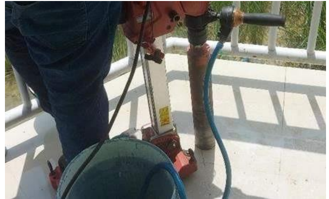
Gambar 2. Core Drill Elemen Struktur Bangunan
