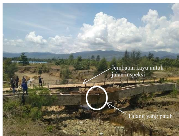
Gambar 1. Eksisting Talang D.I. Opiyang
